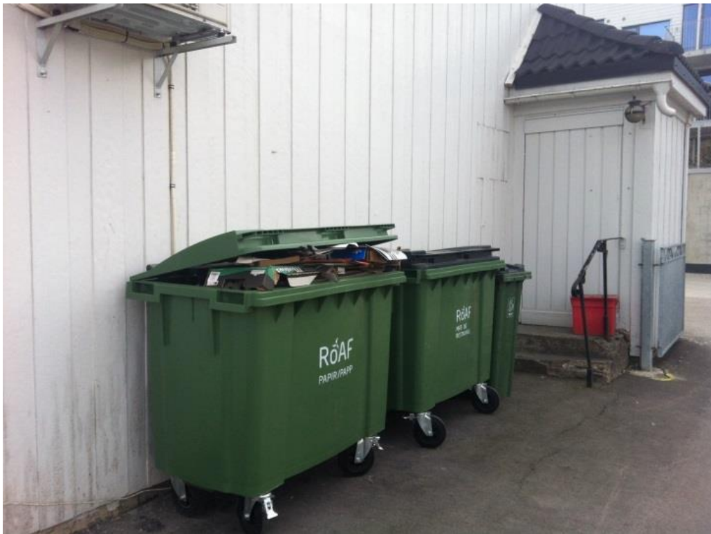
Figur 18: Plassering av avfall inntil bygningsmassen fører hyppigere til bygningsbrann som følge av påsatt brann.
